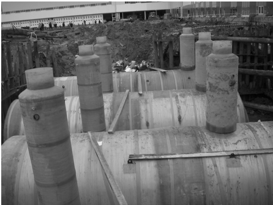
Показан монтаж модулей в котловане.
